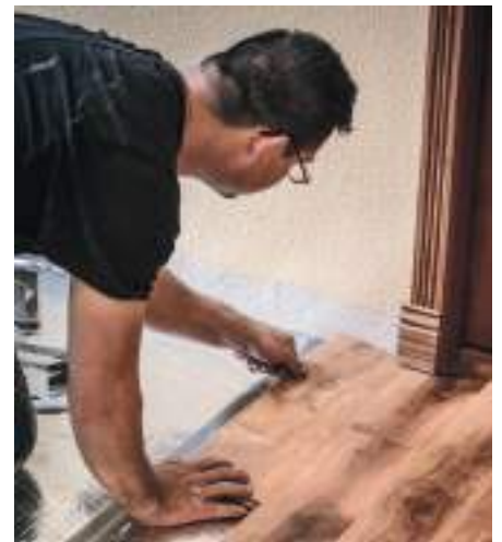
Türzarge Holz zargen sollte man kürzen, um die Dielen darunter schieben zu können. Das ergibt einen sauberen Abschluss.
