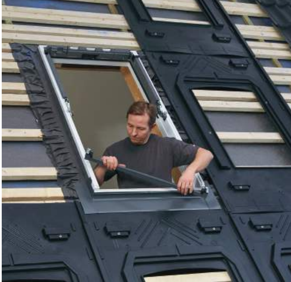
Ein Handwerker montiert das Eindeckrahmenunterteil inklusive Blendrahmen-Abdeckblechen vor dem Einbau der Solarmodule – hier über Kunststoffwannen des Herstellers GSE.
