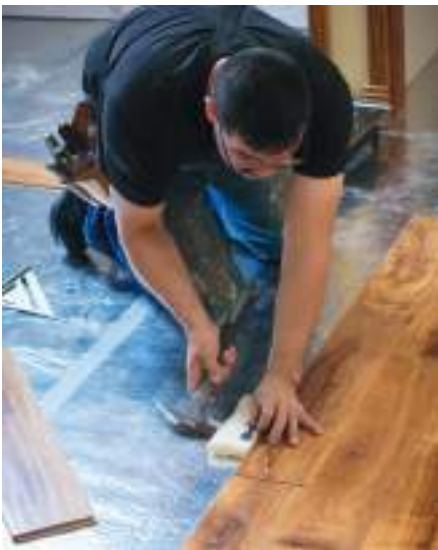
Schlagholz So gelingt eine fugenfreie Verlegung. Niemals direkt auf die Nut oder Feder einer Diele schlagen.
