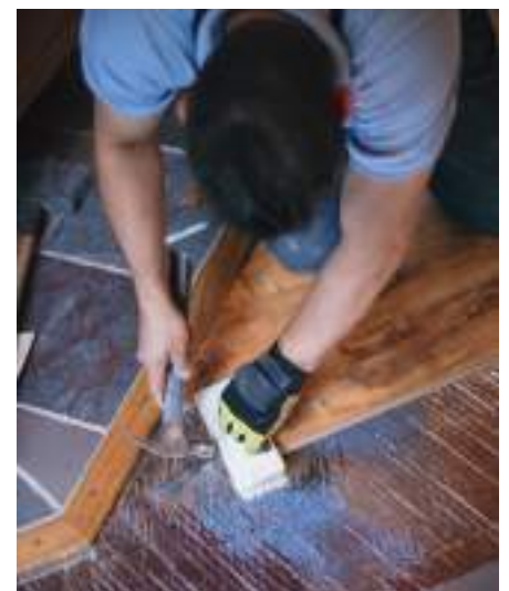
Maßarbeit und Geduld Sorgfältiges Messen und genaues Sägen – so meistern Sie auch schwierige Verlegestellen.
